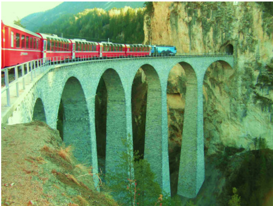
Bild 1: Landwasserviadukt nach der Instandsetzung am 25. Nov. 2009
